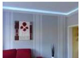
Durch die Verwendung von RGB LED Bändern plus entsprechendem Controller kann zusätzlich die Farbe der LED-Beleuchtung nach Belieben verändert werden
