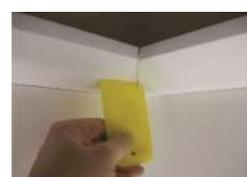
Die Längsfugen zwischen Wand und Stuckprofil ebenfalls mit Stuckkleber verfugen. Da dieser Kleber sehr gut zu überstreichen ist und sich in der Vergangenheit wesentlich besser als Acryl bewährt hat.
